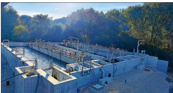
Nach der Inbetriebnahme des neuen Belebungsbeckens werden im Sommer 2024 die 5 Tropfkörper rückgebaut, wodurch eine Freifläche auf dem Kläranlagengelände entsteht. Der Rückbau der Tropfkörper muss bis Ende 2024 abgeschlossen sein, damit die darauffolgende Renaturierung des Sulzbaches durch das Ingenieurbüro Geitz & Partner erfolgen kann. Für die Arbeiten am Sulzbach wird eine Baustraße hergestellt, die teilweise auf der Fläche der Tropfkörper liegt.
